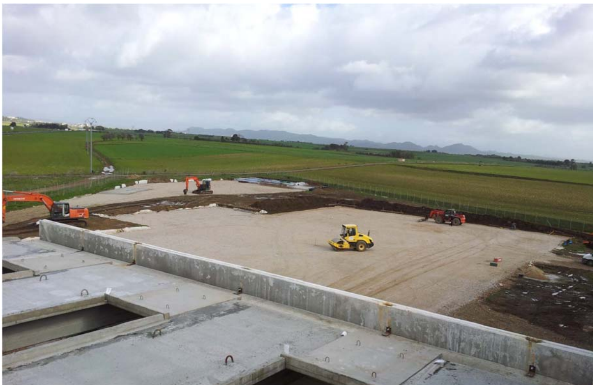
Figura 10: sottofondo superficie spandimento e asciugatura
