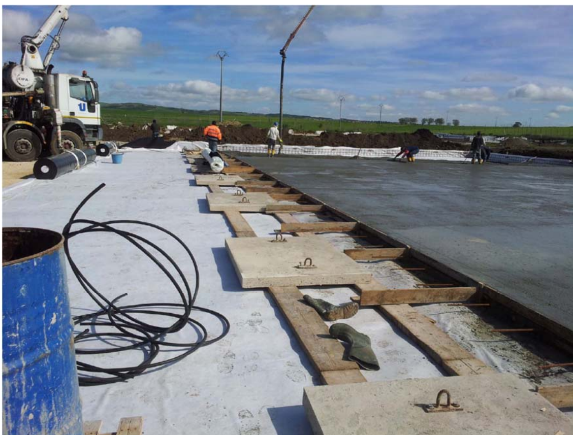
Figura 11: Pavimento su impermeabilizzazione
